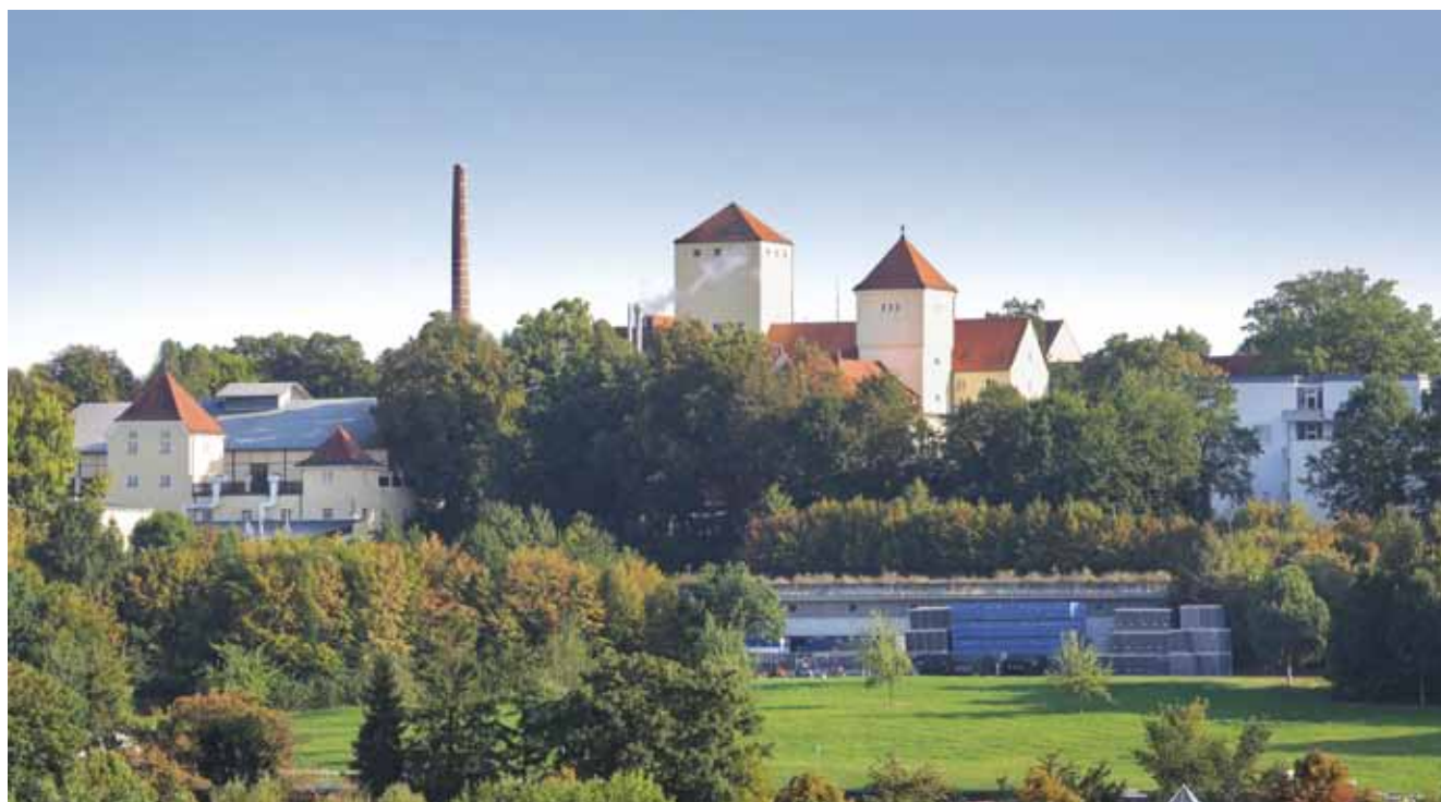
05 Der Weihenstephaner Berg von Nordwesten mit den Brauereigebäuden und den beiden markanten Wassertürmen, Fotografie, Rainer Lehmann, 2016 (Stadtarchiv Freising, Fotosammlung)
