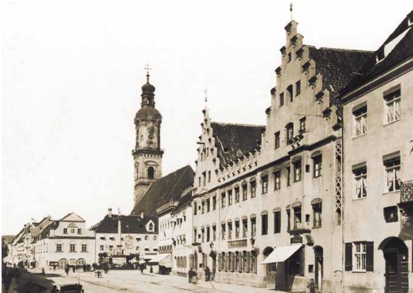
01 Hauptgebäude des ehemaligen Heigl- bzw. Sporrerbräus mit seiner imposanten neugotischen Schaufassade an der Unteren Hauptstraße; Franz Seraph Sporrer hatte die ursprünglich drei eigenständigen Anwesen des Heiglbräus, des Heiglbackers und des Weindlbräus (v. l. n. r.) um 1838/40 zu einem Gebäude zusammengefasst, Fotografie, Franz Röss, um 1885 (Stadtarchiv Freising, Fotosammlung)
